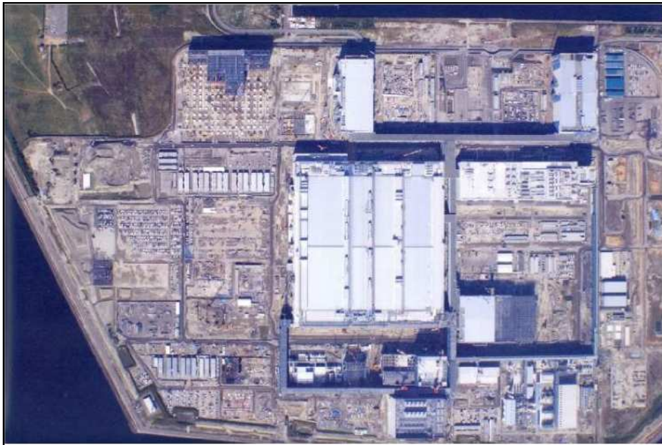
建設工事中のシャープ堺コンビナートの全景
