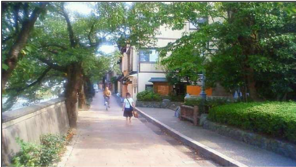
金沢・浅野川の左岸側に沿った道路（左側に高さ1メートル強のパラペットがあり、その切り欠き部から浸水が発生した）
