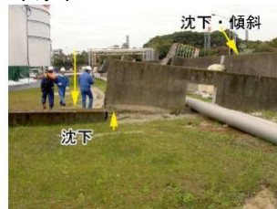
タンクの支柱の座屈と配管の損傷 市原市
