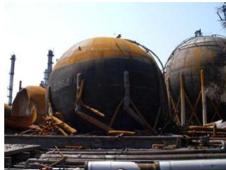
タンクの支柱の座屈と配管の損傷 市原市
