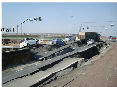
江合川左岸27.6k付近(堤防亀裂・沈下)
