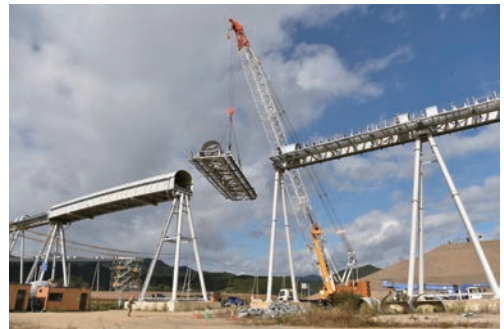
2015年10月 岩手県陸前高田市 ベルトコンベアーの解体始まる
