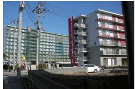
2015年 宮城県気仙沼市 10階建ての公営住宅が姿を現した
