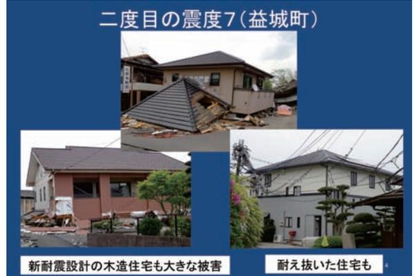
工学の分野で地震動の強さを捉えるとき、通常は加速度と速度で捉えます。益城町の本震は、大きい方のEW方向の加速度は約1157gal、速度は約127kine発生しています。工学の分野では、1000gal、100kineを超えるのは非常に恐ろしい地震動だと捉えています。
