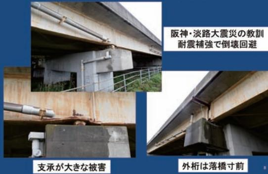
熊本の高速道路は九州の中で最初にできたエリアで、非常に古いのです。兵庫県南部地震で阪神高速のピルツ橋の橋脚が倒れ復旧に非常に時間を要した反省を踏まえて、この高速道路は、周辺を20cm、鉄筋コンクリートで増厚する耐震補強が終わっていました。高速道路は災害時の緊急輸送道路網の中で一番重要なものですから、最優先で耐震補強をしてあったのです。それによって、橋脚の傾斜や倒壊という最悪の事態は免れました。ただし、支承部分や継ぎ目の部分は少し傷みました。それを約2週間で応急復旧し、連休前にはいったん停止しながらも通せたわけです。これが物資の輸送という面で、熊本の復旧に対して非常に大
