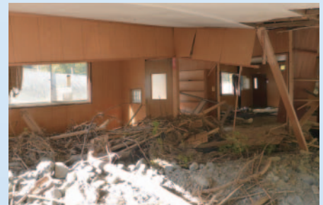
土砂による家屋被災の状況
