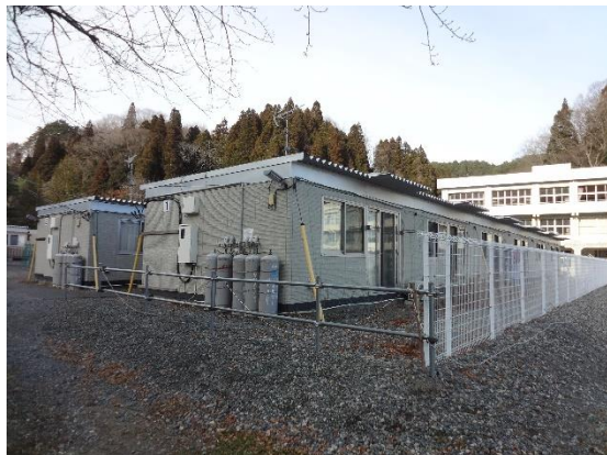
図 1-1 鉾ヶ崎小学校校庭の仮設住宅
