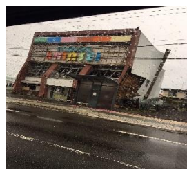
むかわ町の被害
