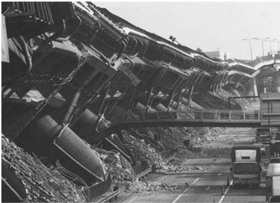
阪神高速 3 号神戸線(ピルツ橋)の倒壊
