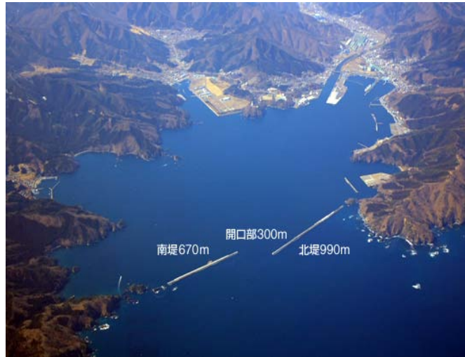
図 3－1－2－2 釜石港の防波堤
