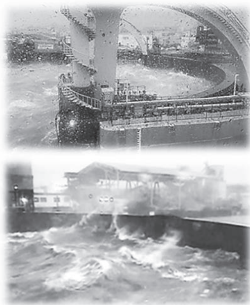
写真1 平成30年9月の台風第21号襲来時の尻無川（上）及び安治川（下）防潮水門の開閉状況.
