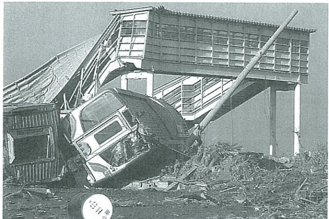
津波で崩壊したJR常磐線新地駅一福島県新地町谷地小屋で2011年3月17日、神保圭作撮影
