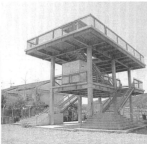
高知県黒潮郡の沿岸部に設置された津波避難タワー 2012年3月、小坂剛志撮影
