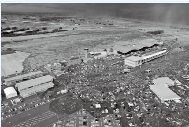
大津波に襲われ、道路や建物のみ込まれた山台空港。空港の海側には貞山堀があったのだが…。=2011年3月11日
