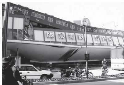
図3 阪神・淡路大震災で倒壊した阪急電鉄伊丹駅 (人と防災未来センター提供)
