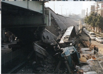
国道高架橋の倒壊 (H7.1/灘区)
