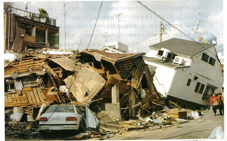
1階部分がわからないほど倒壊した家屋 (H7.1.18/灘区)
