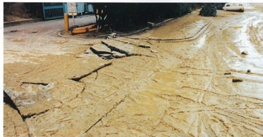
液化化現象により泥水が噴出した道路 (ポートアイランド/中央区)
