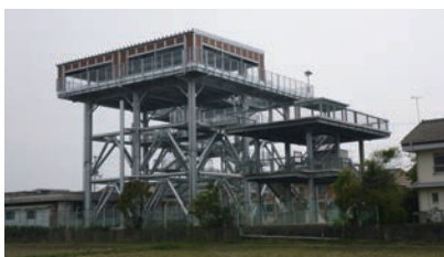
津波避難タワー
