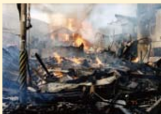
1/17神戸市灘区の火災現場 資料番号0000420-001012-001.00004
