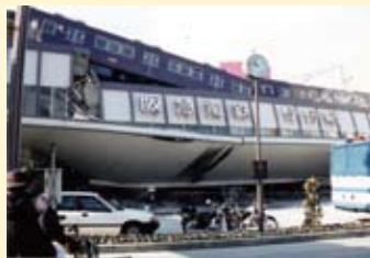
1/17阪急伊丹駅の被災状況 資料番号0000420-001001-001.00008
