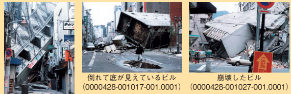
隣のビルにもたれかかっているビル (0000428-001003-001.0003)
