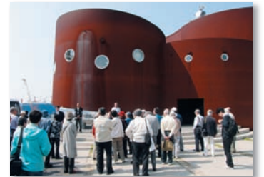
建物の前での説明。外壁は腐食を防ぐ特殊な錆(さび)で覆われています
