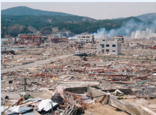
町の中心、志津川市街地の被害状況
