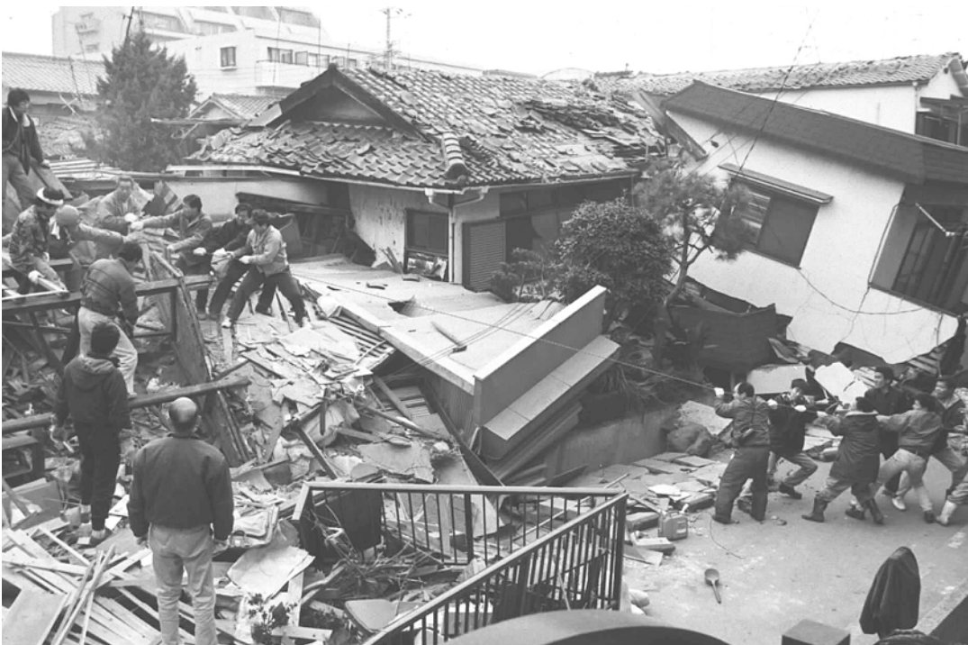
第2 - 2 - 1写真 阪神・淡路大震災で倒壊した住宅(神戸市灘区) (神戸新聞社提供)
