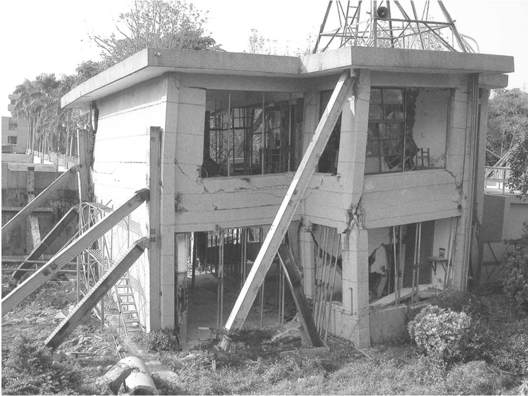
第2 - 7 - 4写真 震災の教訓を伝える「921地震教育園區」で、保存工事が進む被災校舎(台中県)
