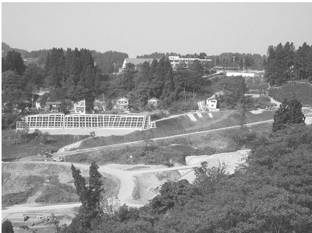
第2 - 4 - 6写真 道路の整備などが進む旧山古志村(長岡市、2006年10月)
