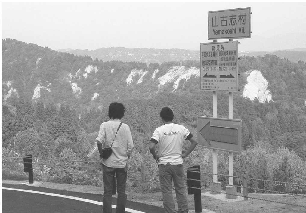
第2 - 4 - 5写真 山の至るところが崩れた旧山古志村(長岡市と小千谷市境)
