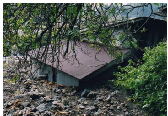
第 3-1-5 図 旧竹野町における被害 撮影：嶽山洋志
