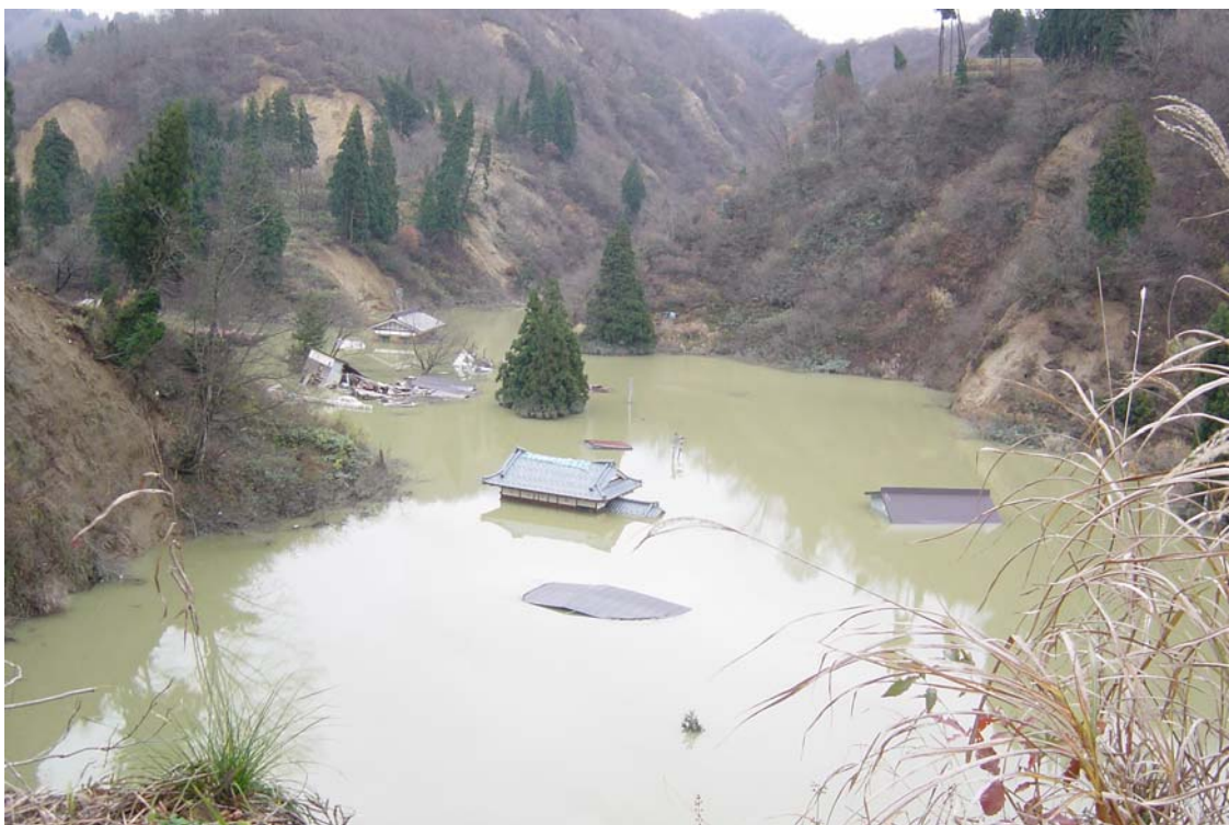
第 3-2-8 図 家屋浸水状況（木籠地区）
