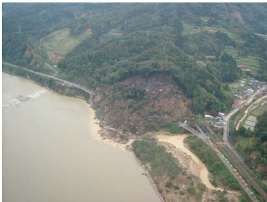
第 3-2-2 図 県道、鉄道の被害（妙見地区）
