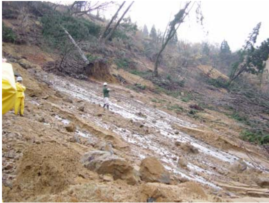
第 3-2-6 図 すべり面（東竹沢地区）
