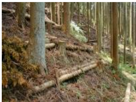
緑税を活用して間伐木による土留工を設置 32)
