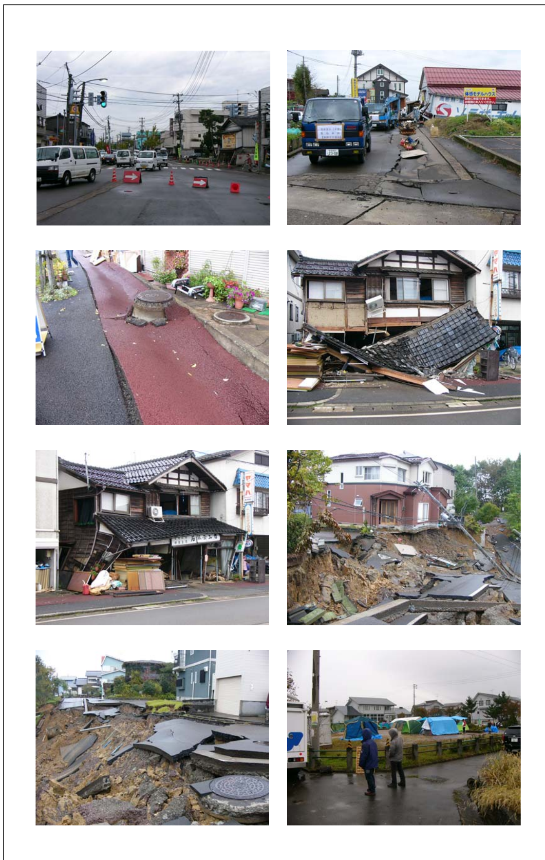
第 5-2-13 図 長岡市東部における被害状況
