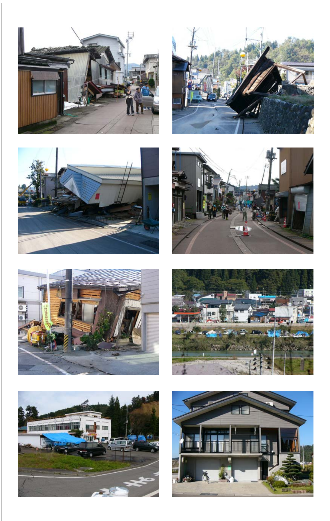
第 5-2-16 図 川口町魚野川右岸地区における被害状況
