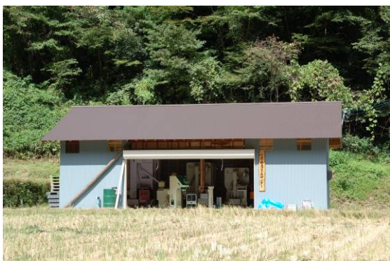
地区で共用しているライスセンター
