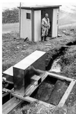
集落の傾斜を利用した手作り発電所
