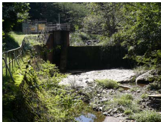
第10-3-6図 金谷隧道の取水口
