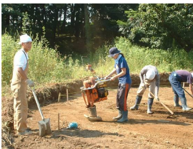
アトムハウス建築のための敷地整地 85)
