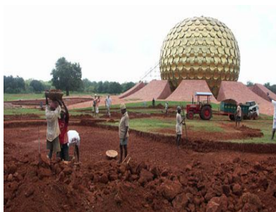
マトリマンドリ付近で掘削する人々 49)
