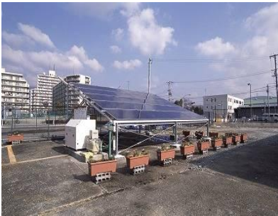
くるくる発電所に設置された太陽光発電パネル 80)
