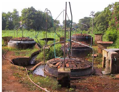
バイオガス発生器 50)
