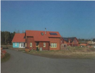
太陽熱温水システムとウッドチップボイラーを備えた家 1)
