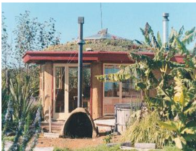
セルフビルドのエコ建築 (4)
