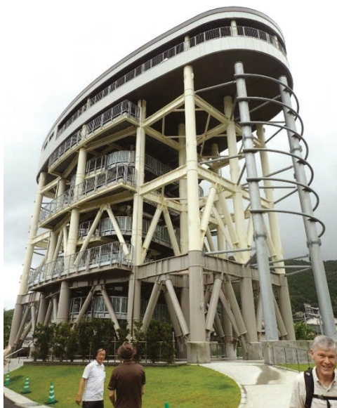
図 5.2.1.2 佐賀地区津波避難タワー全景
