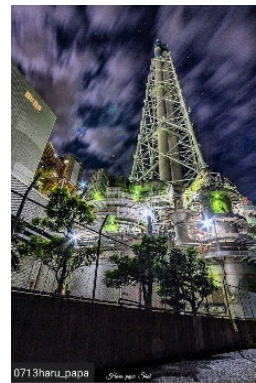
写真 高砂火力発電所 (高砂市)
