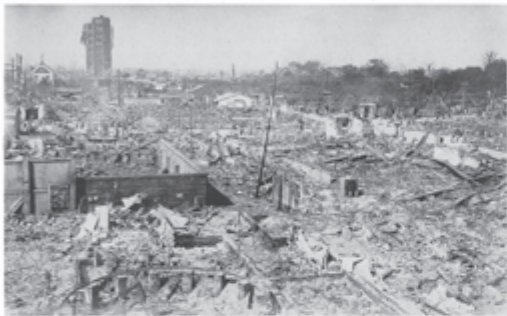
関東大震災で壊れた東京・浅草付近。当時の名所だった12層建ての浅草園(左奥)も崩壊した
