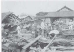
倒壊した民家で進む救出作業。沿岸は津波にも襲われた一見・野村伊勢守市
