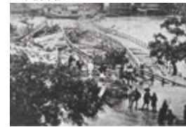
安治川橋にかかる流材(明治18年(1885)の洪水の橋梁被害)(引用:大阪春秋)
