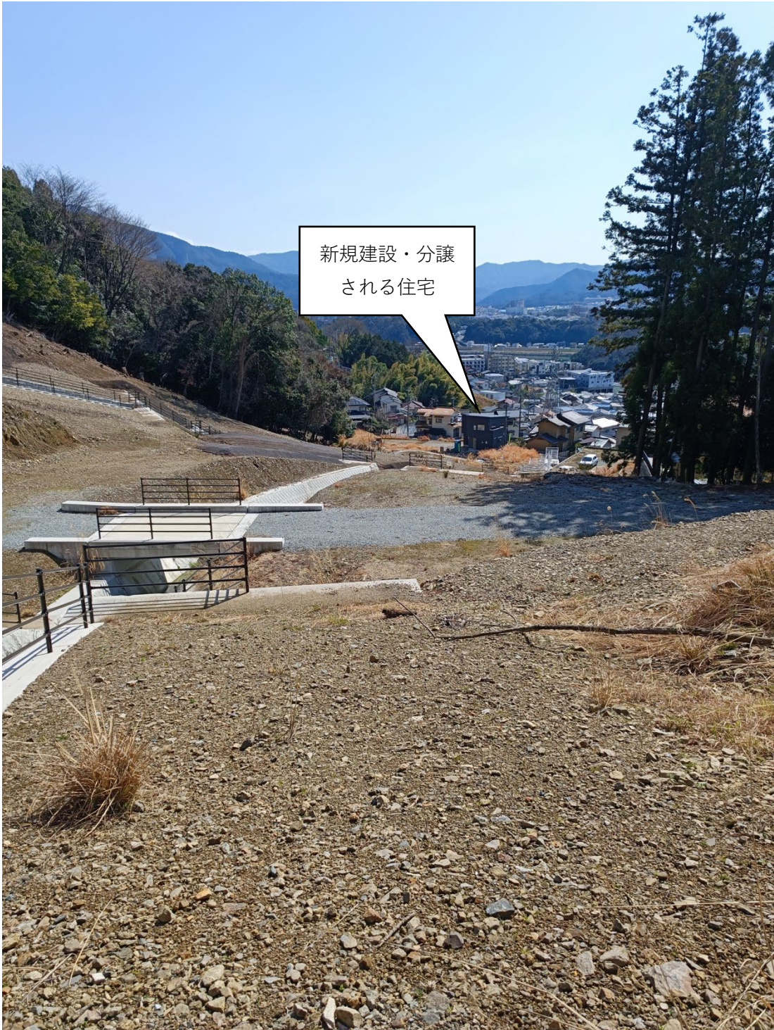
写真 2-4-1 平成 26 年豪雨災害で被害を受けた広島市安佐南区八木地区での 住宅新築の様子
