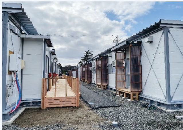
鵜川地区の仮設住宅
