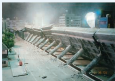
5:46の衝撃[阪神高速道路 スタジオ撮影記録写真]
