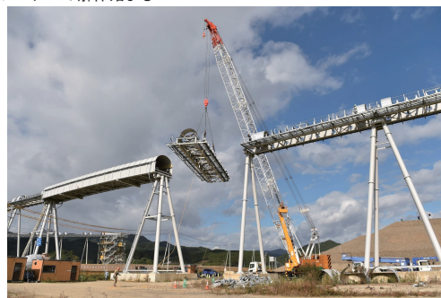
2015年10月 岩手県陸前高田市 ベルトコンベアーの解体始まる
