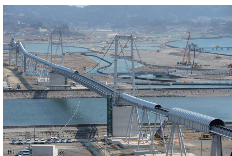
山から街へ土砂を運ぶ全長3kmのベルコンベアー 総工費1200億円 岩手県陸前高田市(2014/03)
