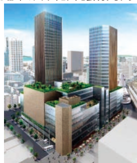
北東から見る建物外観
