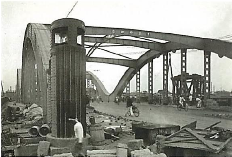
工事終盤の様子。鋼製のアーチ橋で、1929(昭和4)年に竣工した。
