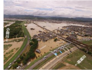
⑦小田川における浸水被害 (岡山県倉敷市)
