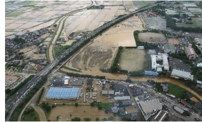
⑥桂川における浸水被害 (福岡県朝倉市)
