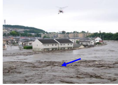
①白川における浸水被害 (熊本県熊本市)
