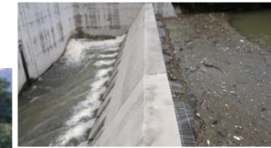
洪水時の放流状況
