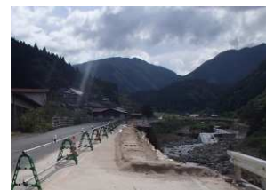
応急復旧工事完了後
