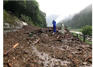
国道482号線 土砂流出
