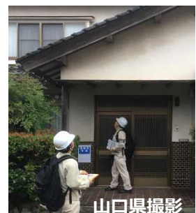
建物の被災状況を確認する応援職員
