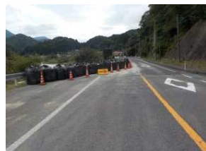
応急復旧工事完了後
