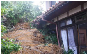
土砂の崩落（米子市）
