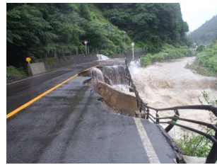
国道373号線 護岸崩壊
