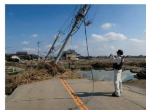
現地調査（常総市）
