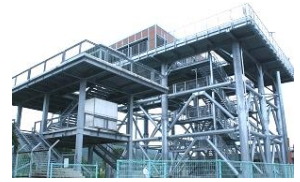
現地視察(津波避難タワー)
