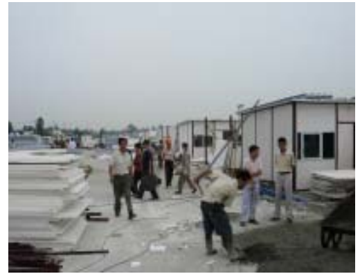
写真13 仮設住宅の建設現場
