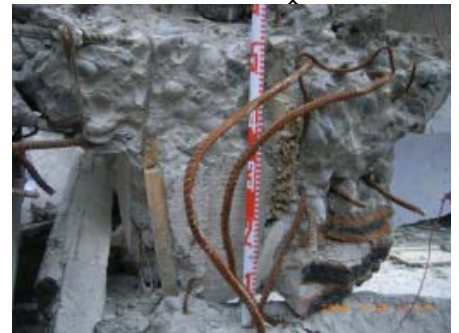
写真2 聚源中の柱の断面
