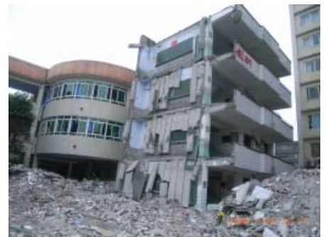
写真3 新建小の被災状況
