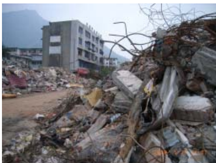
写真5 漢旺鎮の被災状況1
