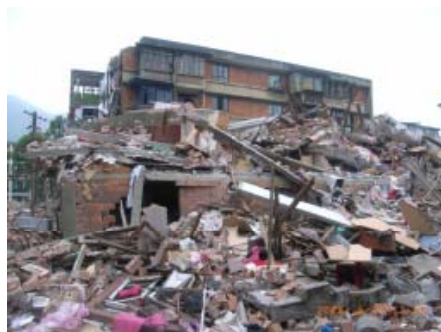
写真6 漢旺鎮の被災状況2
