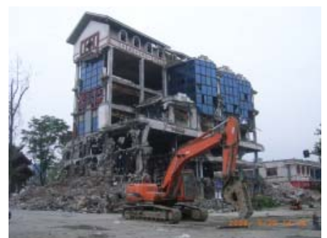
写真4 都江堰市中心部の建物
