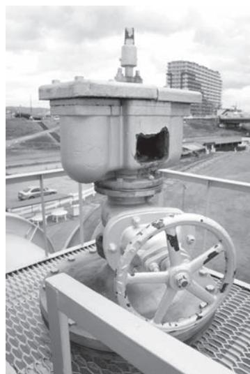
写真-3 枚方水管橋空気弁の被害
