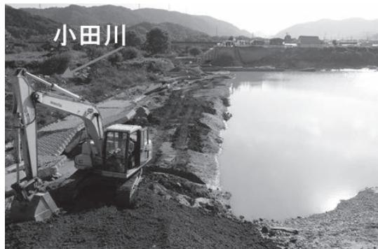
図7 小田川 3.4km 左岸の堤防決壊状況
