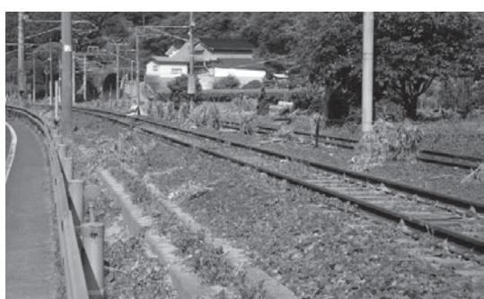
図17 日羽と美袋間の伯備線の浸水状況
