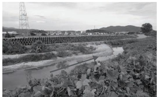
図27 砂川決壊箇所の土砂の堆積状況
