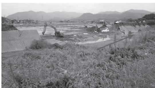
図10 真谷川0.5km左岸の堤防決壊状況
