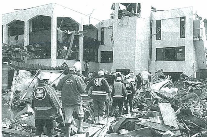
地震発生当初、災害対策本部が置かれていた市民会館を捜索する消防団員ら。岩手県陸前高田市で2011年3月13日、兵藤公治撮影
