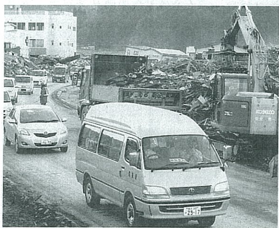
東日本大震災発生から約2週間後、がれき撤去が進む岩手県宮古市田老の国道45号の様子
